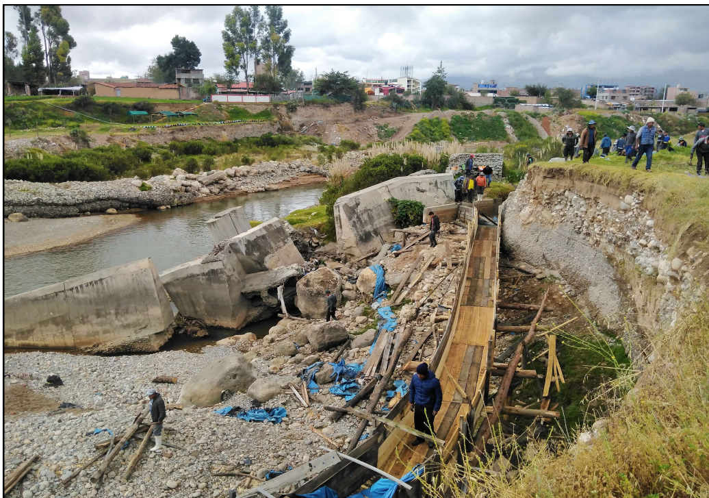
FOTO N°02: SE OBSERVA LA BOCATOMA DE LA COMISION DE REGANTES HUAMANCACA DESTRUIDO
